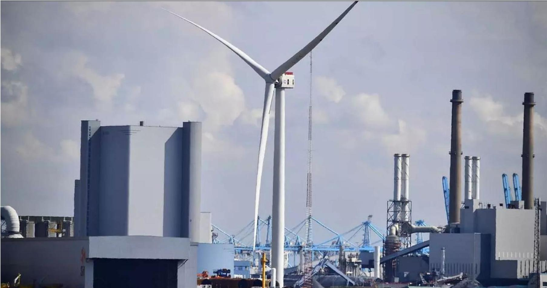
Haliade 14 MW von GE Okt.2021 in Rotterdam zur Erprobung aufgestellt. Soll in der Nordsee 74 Mio. kWh/a erzeugen.
